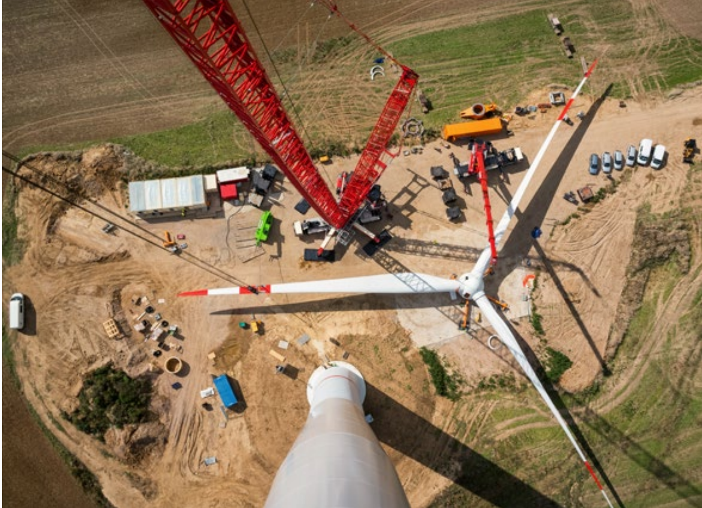
Proceso de montaje de las palas del rotor sobre una turbina eólica.
